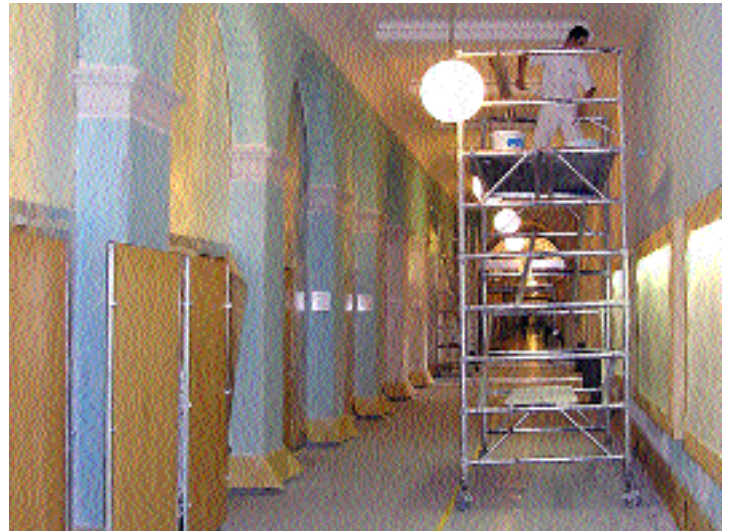
Die Gänge im E- und F-Geschoss sowie die Wände in der Haupthalle erhielten neue Farbanstriche. Fotos: Regina Schwendener
